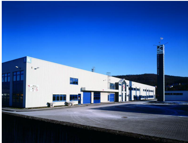
Eines von drei Werken der Firma Loch in Idar-Oberstein. Daneben besitzt das Unternehmen auch ein Werk in Brasilien.
