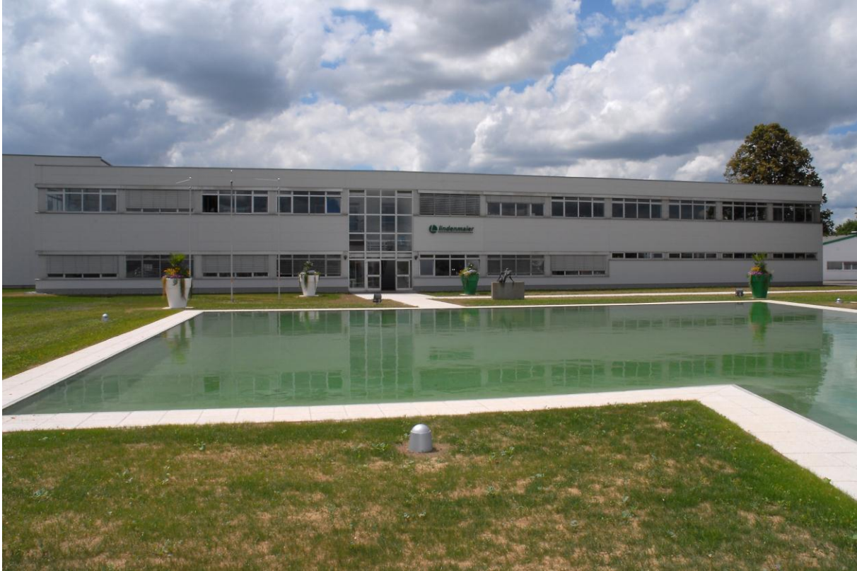
Das neue Werk von Lindenmaier wurde 2007 eröffnet und bietet eine Produktionsfläche von 6000qm.
